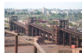
Drie van de vijf torens die verantwoordelijk waren voor een verstoring van de draadloze PROFINET-communicatie.
