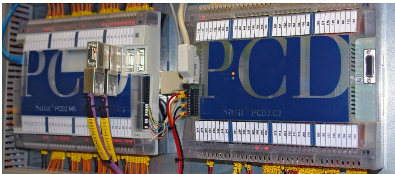
PCD2-BESTURING VOOR NOODSTROOMVOORZIENINGEN INGEZET ALS MASTER-SLAVE VOOR PROFIBUS EN ETHERNET
